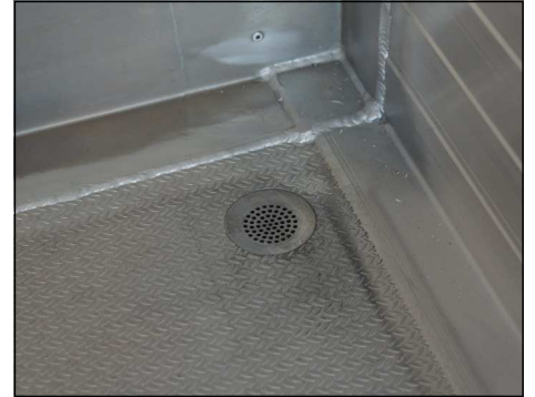
Boden mit Alu-Reiskornblech belegt
